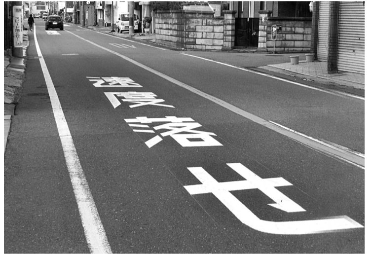
危険な道路上には目立つ表示をしています
